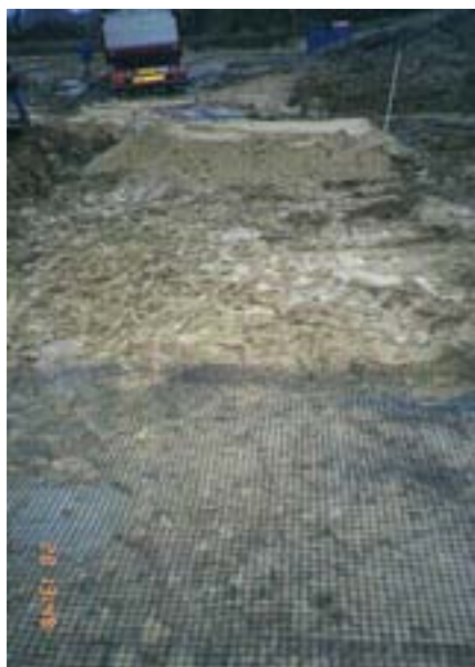
Figur 8: Foto af testfelt og effekt af geonet på forskellige SG-lagtykkelser, /4/.
