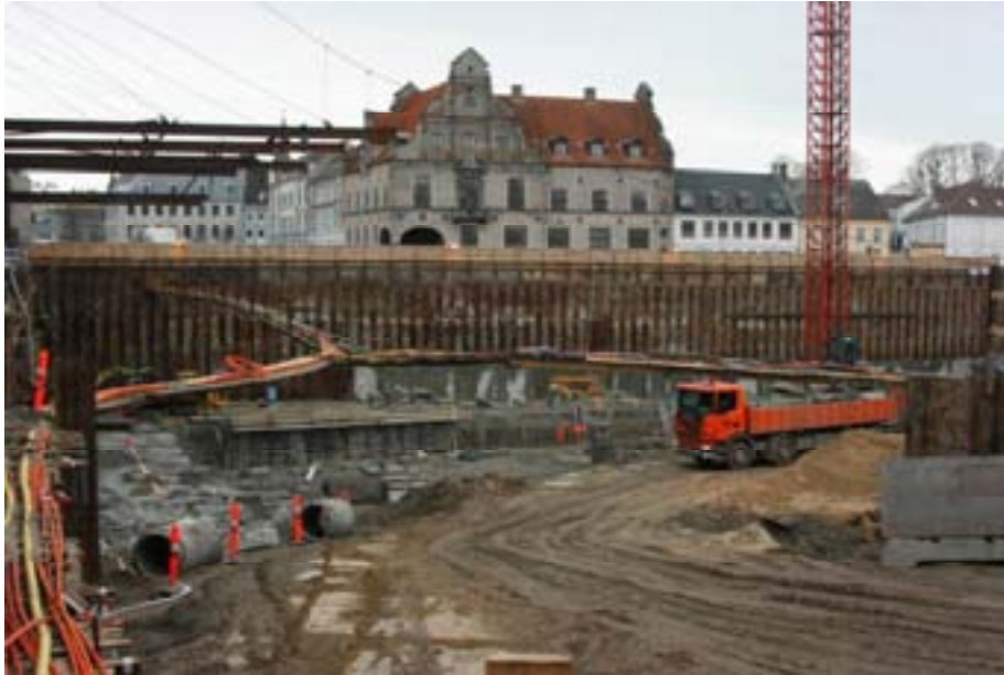
Figur 6 Aalborg Domhus bag byggegrubespunsen
