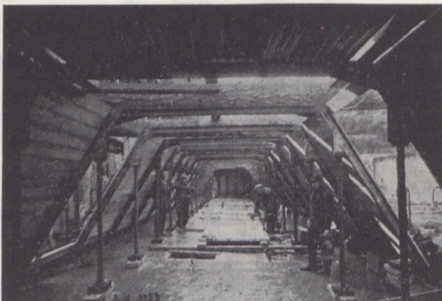
Fig. 6. Arbejdskammer i en trykluftcaisson støbt i dok.
