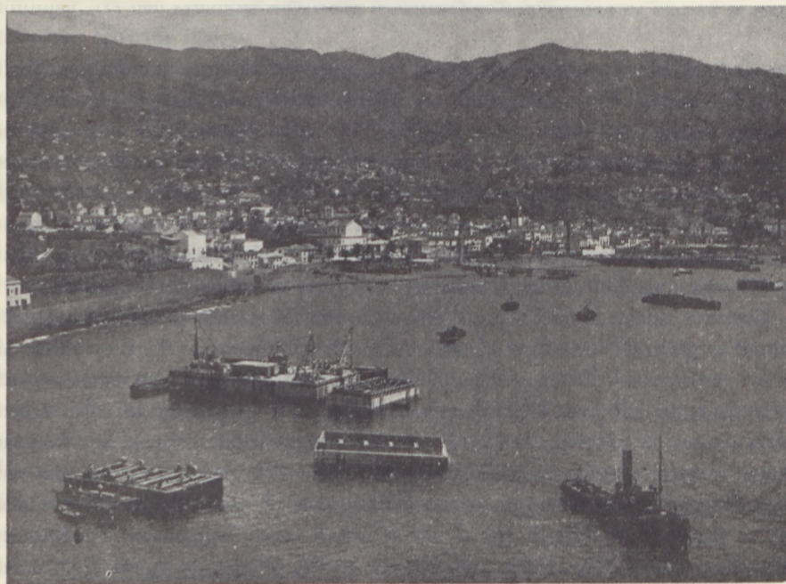
Fig. 25. Støbeanlæg på søen.
