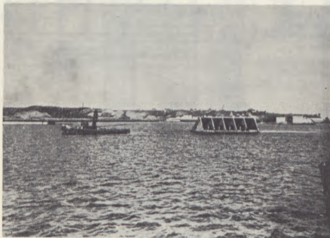
Fig. 17. Bugsering af sænkekasse.
