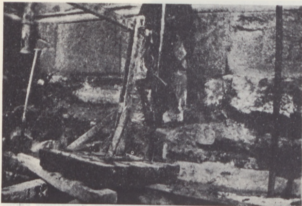
Fig. 8. Vugtebom med saks, der griber om injektionsrøret for at kunne trække dette op.
