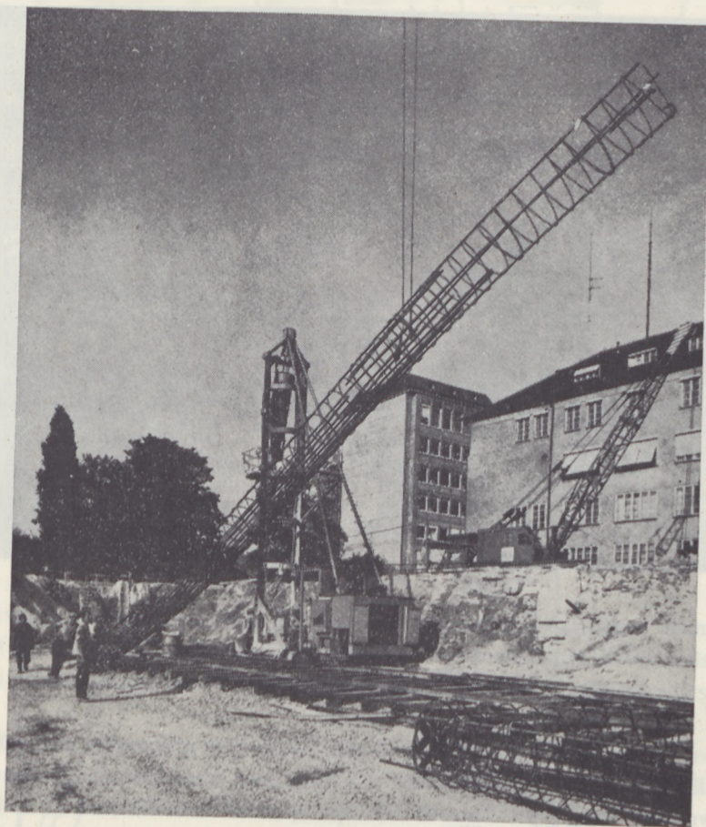
Fig. 17. Armeringen anbringes.
