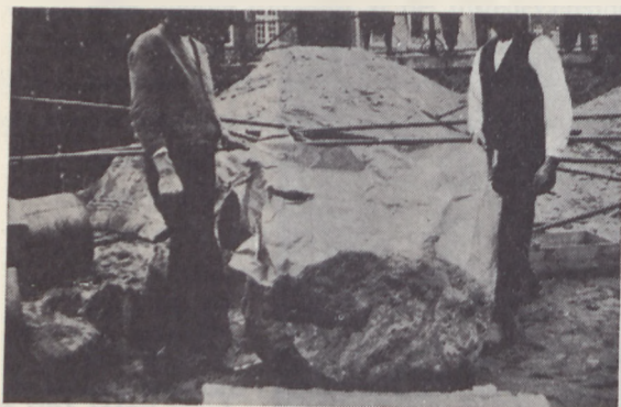
Fig. 10. En blok af forstenet sand gravet fri og kløvet. Den vandrette mørke stribe i den liggende blok er den kanal, det udtrukne injektionsrør har efterladt.
