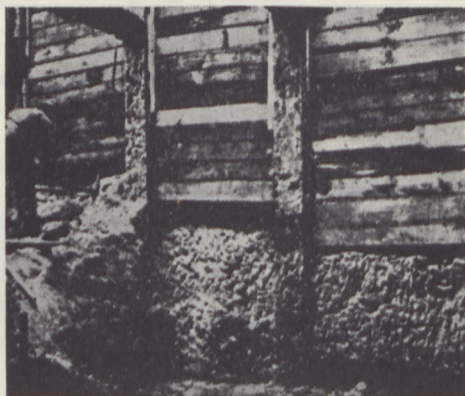
Fig. 16. Sikring af „Nabobygning“ mod sætninger, det løse sand injiceres hvorefter udgravningen foretages med bakke eller trykluftværktøj el. a.
