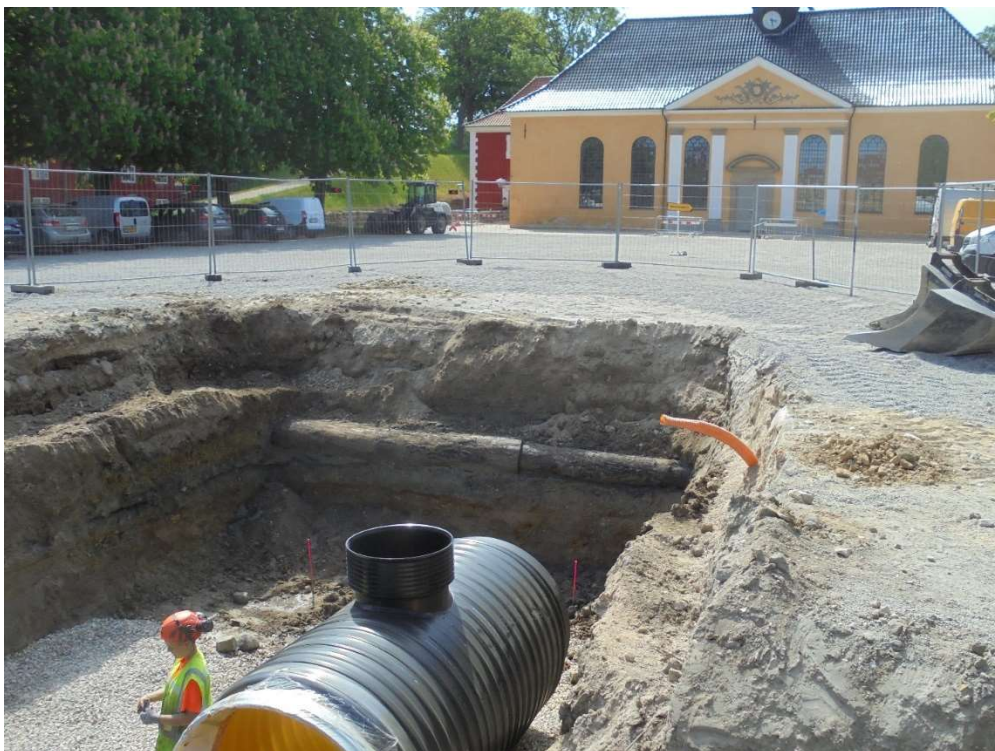
Figur 29: Udgravning for magasinledninger. Udgravningen er stoppet ved fremkomst af en gammel trævandledning. Under trævandledningen ses den tynde mørke stribe jord, det ses at den fortsætter i den venstre udgravningsside.
