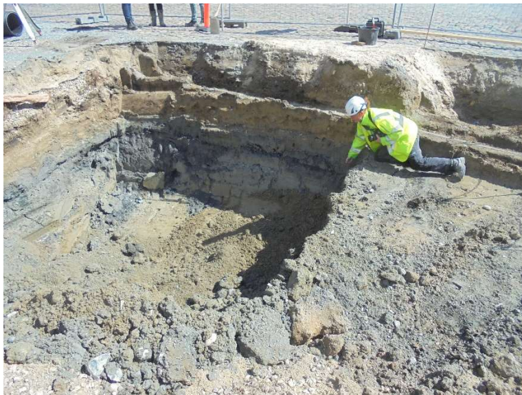
Figur 39: Påbegyndt udgravning for regnvandsmagasin vest for Hovedgaden.
