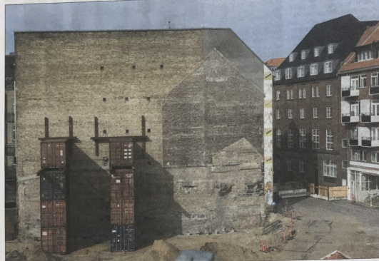
Containere fyldt med sand og stablet oven på hinanden er sat op for at stabilisere ejendommen Vestergade 69. Højgaard Development vil den optimale løsning for ejendommen være at stabilisere den ved efterfundning samt en forstærkning af fundamentet. Foto: Stine Rasmussen
