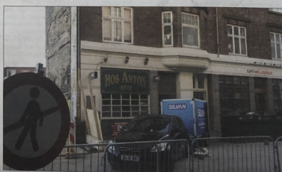
Aarhus Kommune konstaterede i januar, at ejendommen Vestergade 69 var så usikker og ustabil, at den ikke kunne beboes, og samtlige beboere blev derfor evakueret fra ejendommen. Foto: Stine Rasmussen
